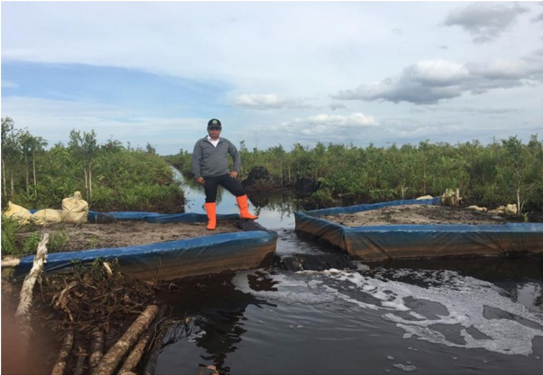
**GAMBAR 10** | Gambar salah satu sekat kanal (canal blocking) di lapangan
