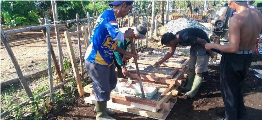
**GAMBAR 87** | Pengecoran Hollow blok pracetak
