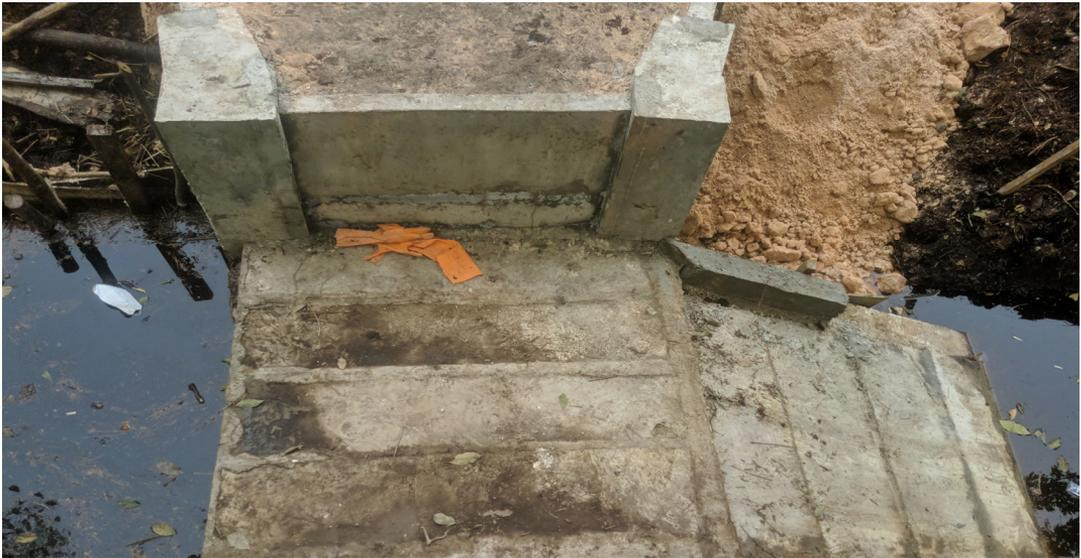
**GAMBAR 73** | Penyusunan Panel Pracetak Peluncur
