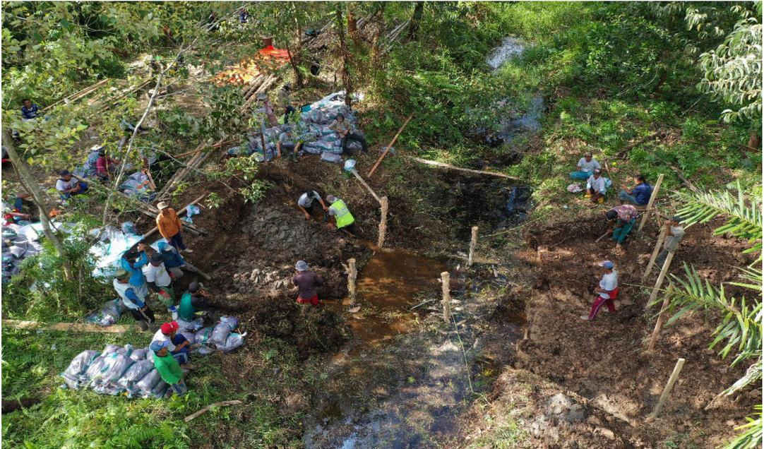
**GAMBAR 29** | Pemasangan empat tiang vertikal
