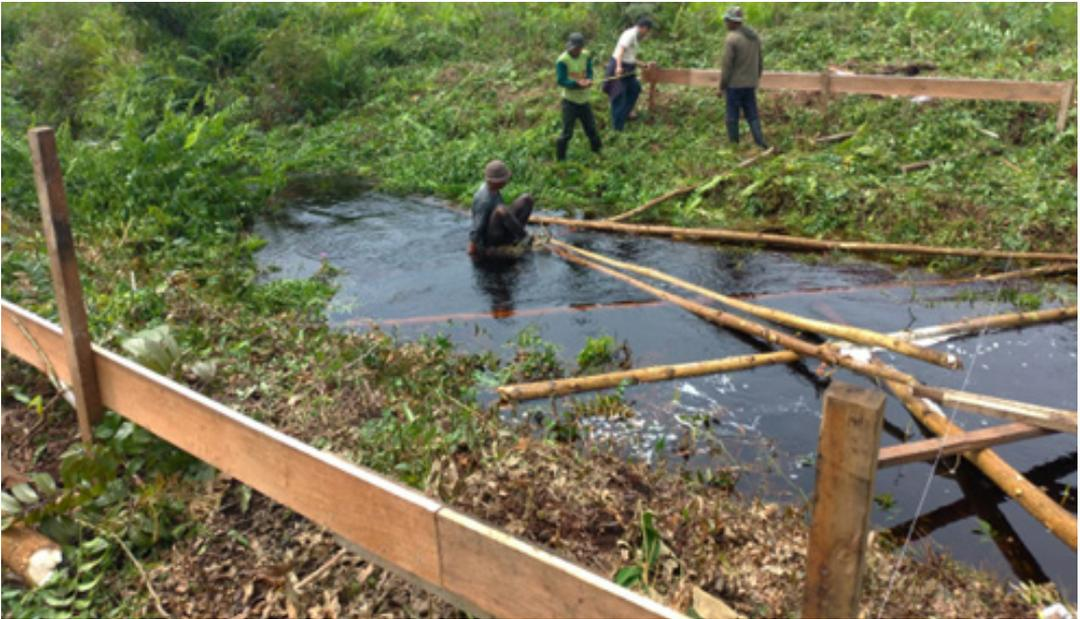
**GAMBAR 79** | Pengukuran dan Pemasangan *Bouwplank*
