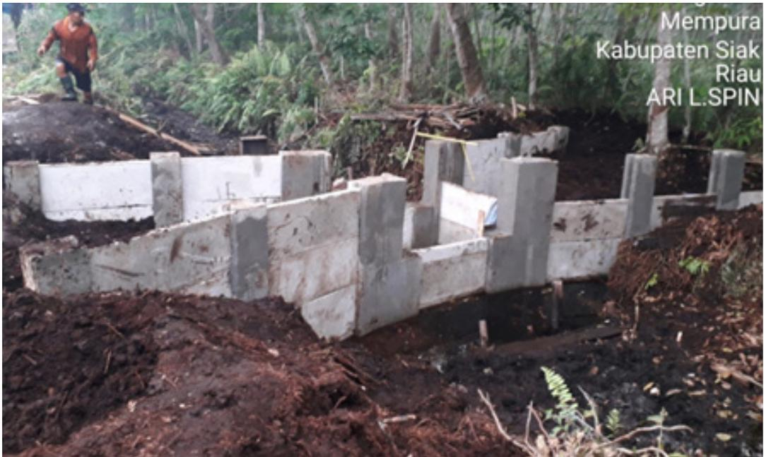
**GAMBAR 71** | Pemasangan panel pracetak
