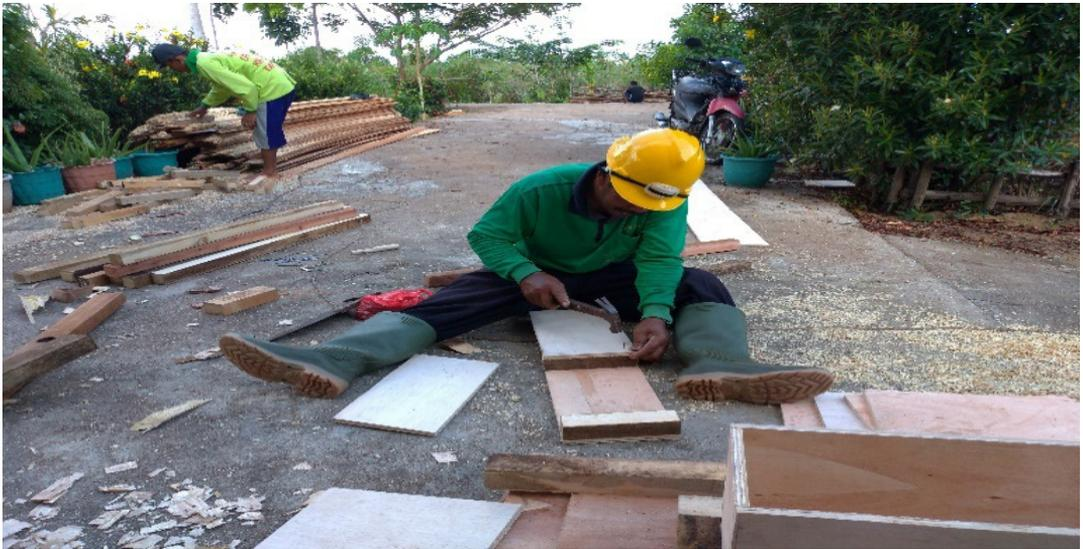
**GAMBAR 82** | Persiapan Pabrikasi Cetakan Hollow block
