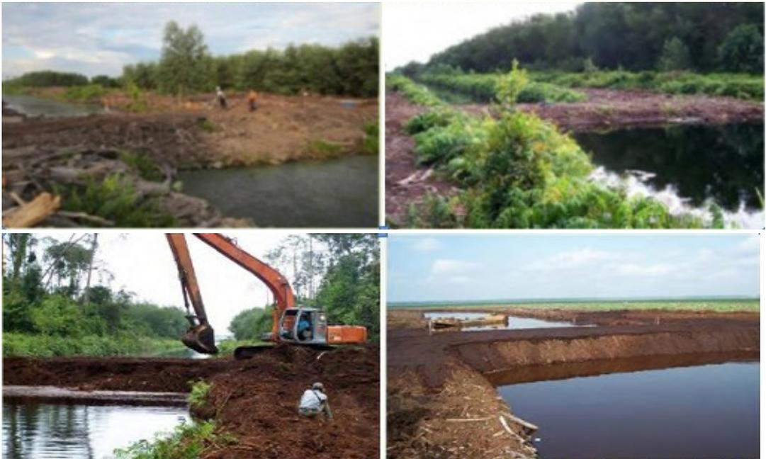
**GAMBAR 18** | Contoh sekat kanal gambut yang dipadatkan
