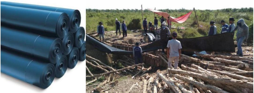
**GAMBAR 32** | Pemasangan *geomembrane*
