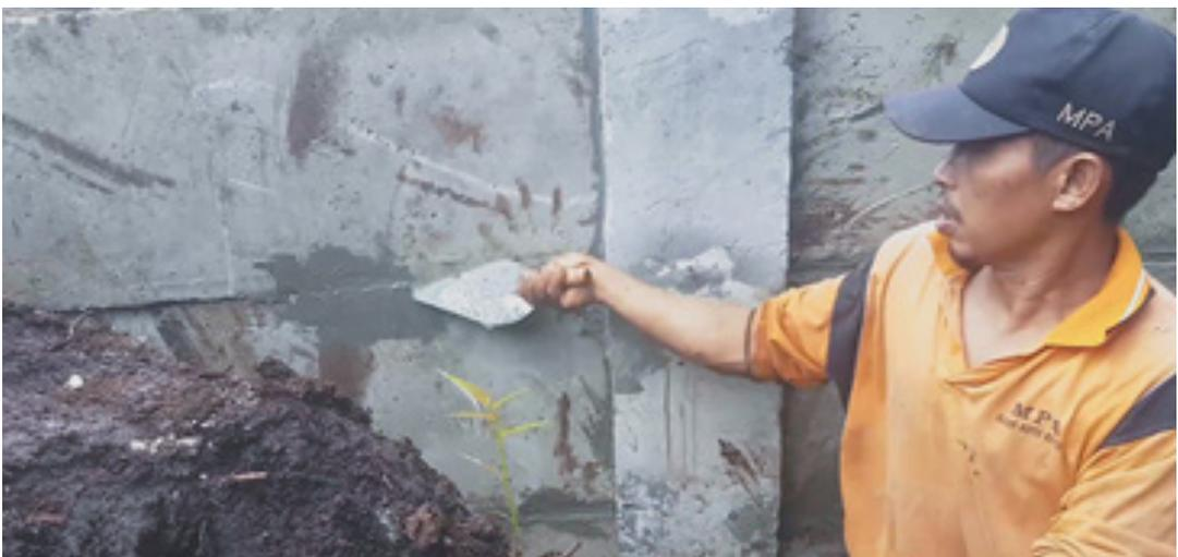
**GAMBAR 74** | Pekerjaan lapisan anti bocor
