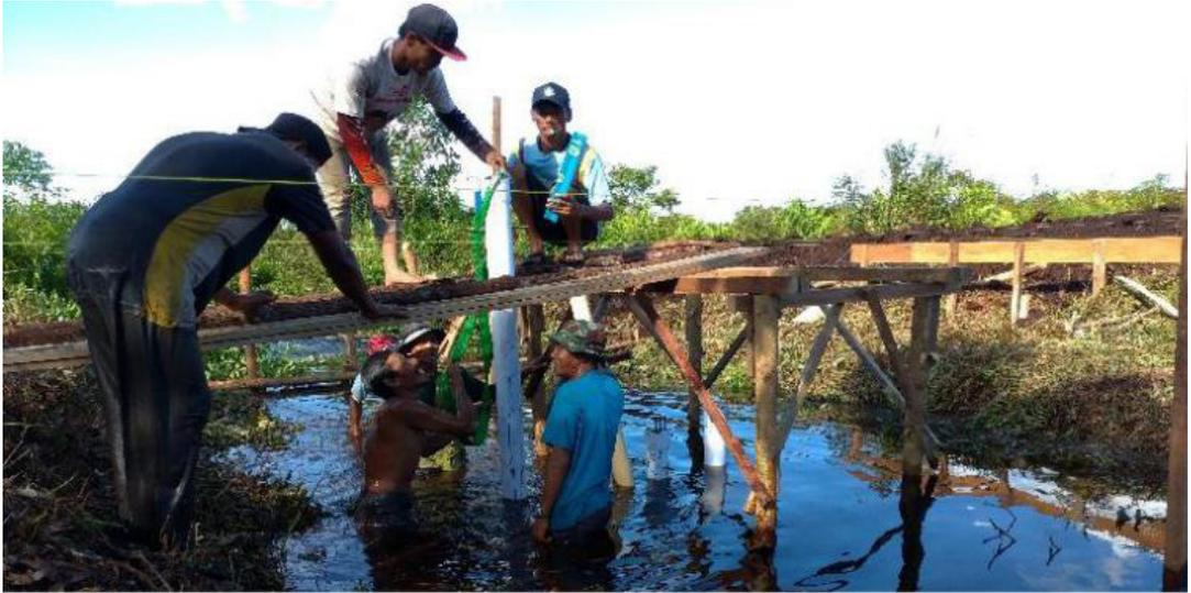
**GAMBAR 91** | Pemancangan Pipa PVC Beton Bertulang
