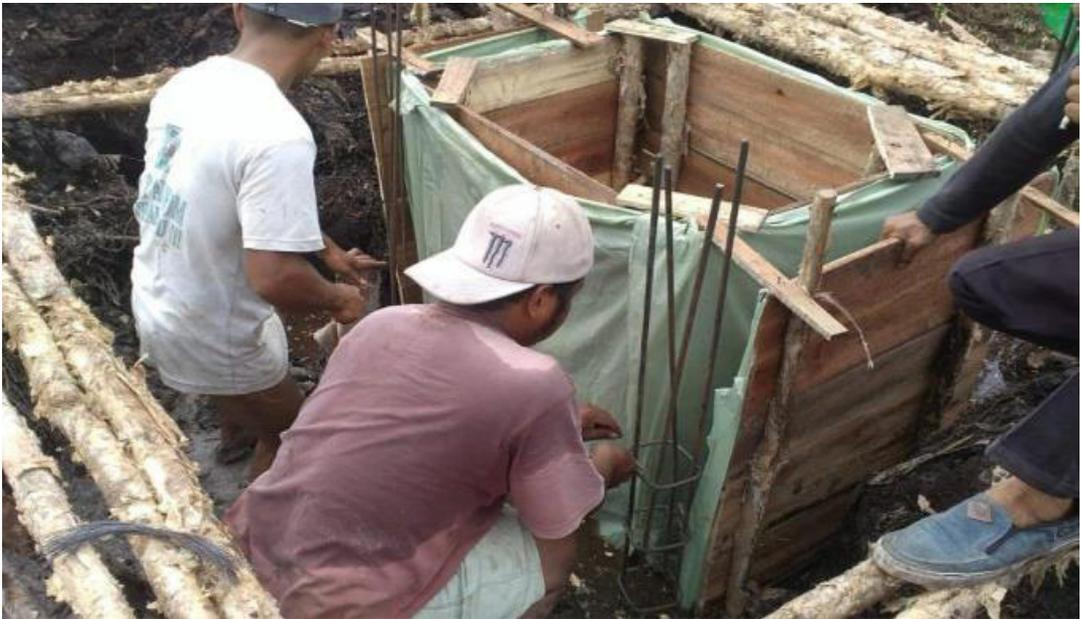
**GAMBAR 46** | Pembuatan bekisting
