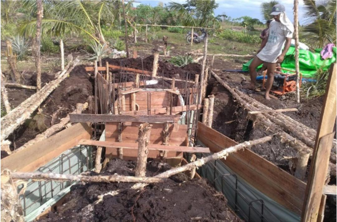
**GAMBAR 48** | Pengecoran Beton Sloof, Dinding, Pelimpasan dan Peluncur
