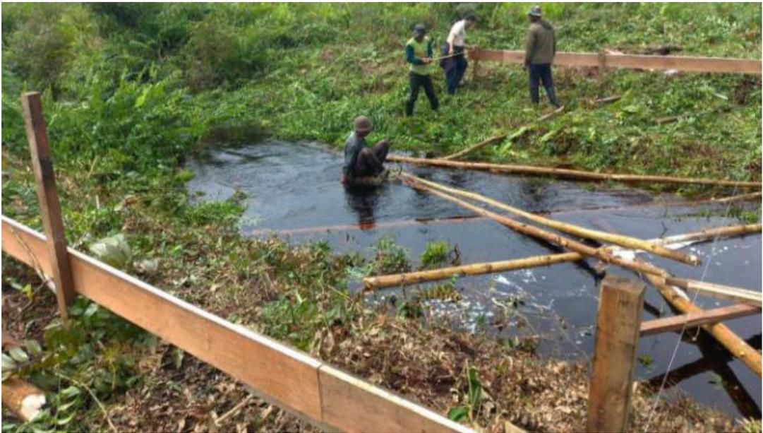
**GAMBAR 40** | Pengukuran dan pemasangan bouwplank
