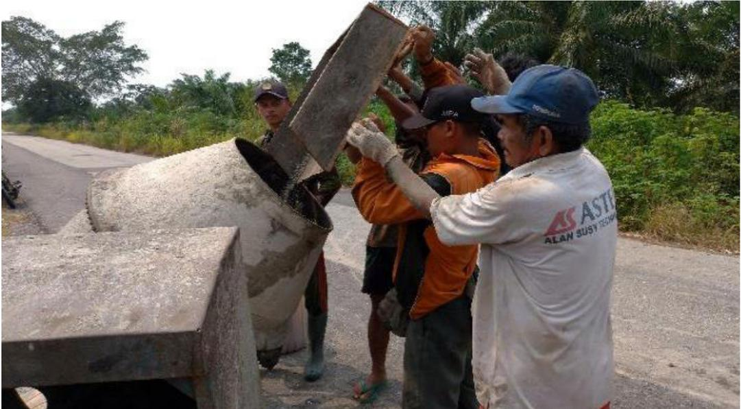
**GAMBAR 61** | Pengecoran Pipa PVC dan Panel Pracetak
