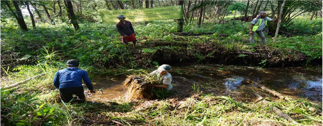
**GAMBAR 25** | Pembersihan lapangan dan pengupasan tanah
