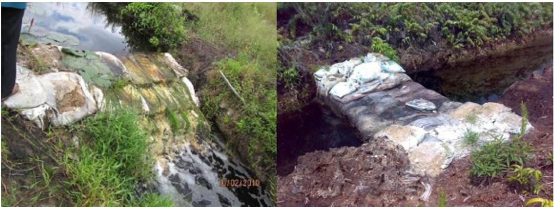
**GAMBAR 17** | Jenis dan Tipe Sekat Kanal dengan Karung Tanah (soil bags)
