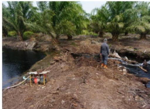
**GAMBAR 105** | Sekat gambut dipadatkan kondisi rusak berat sehingga membutuhkan pemeliharaan rehabilitatif
