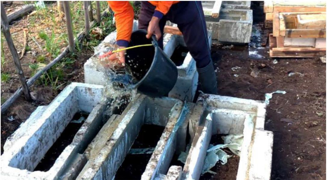
**GAMBAR 89** | Perawatan/*curing* beton
