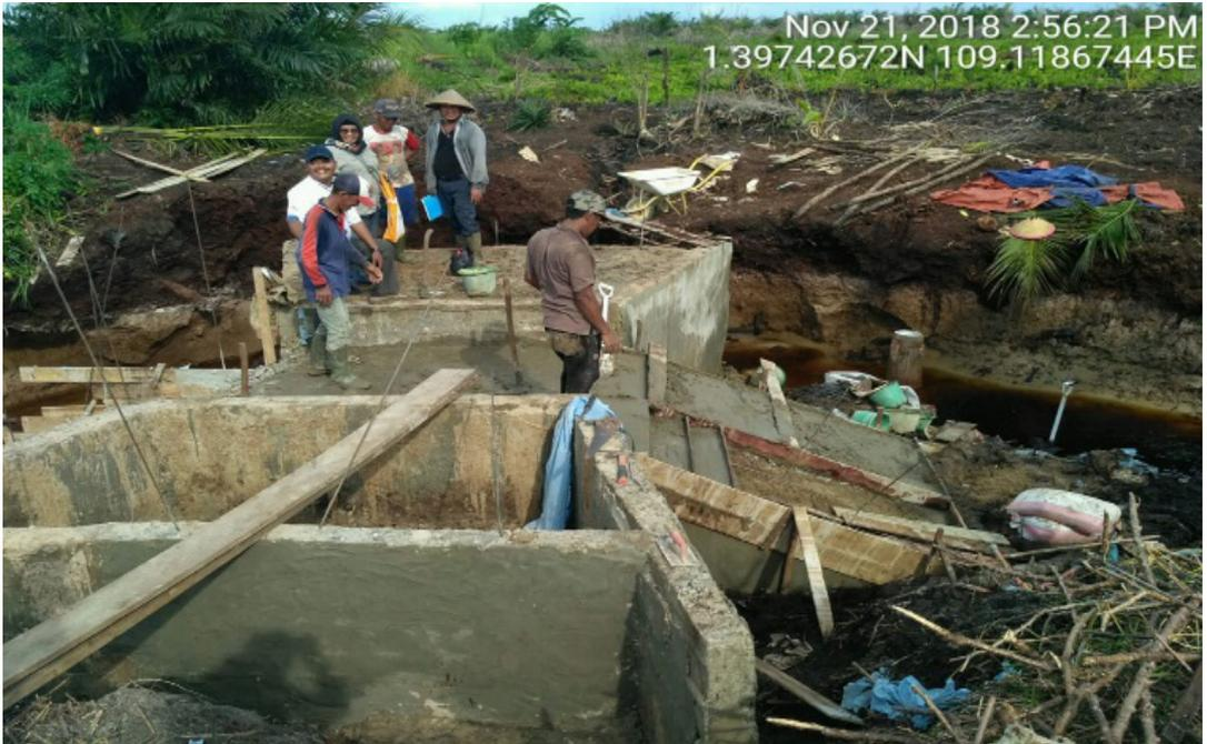
**GAMBAR 49** | Pekerjaan curing
