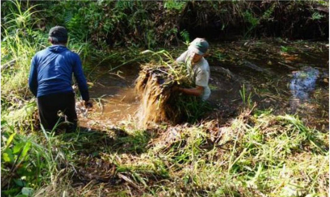
**GAMBAR 39** | Pembersihan lapangan dan pengupasan tanah
