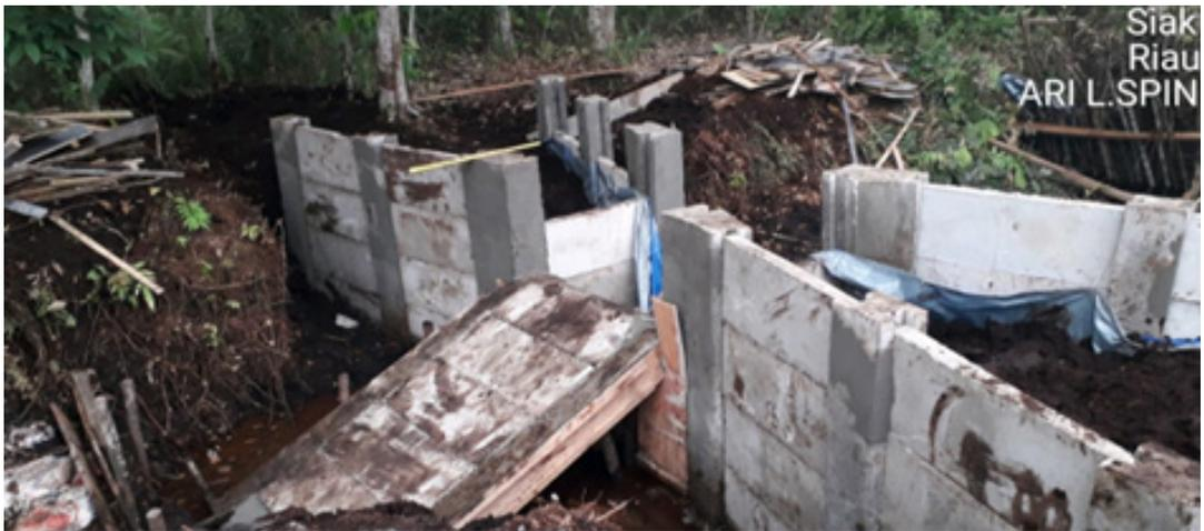
**GAMBAR 70** | Pemasangan geotekstil
