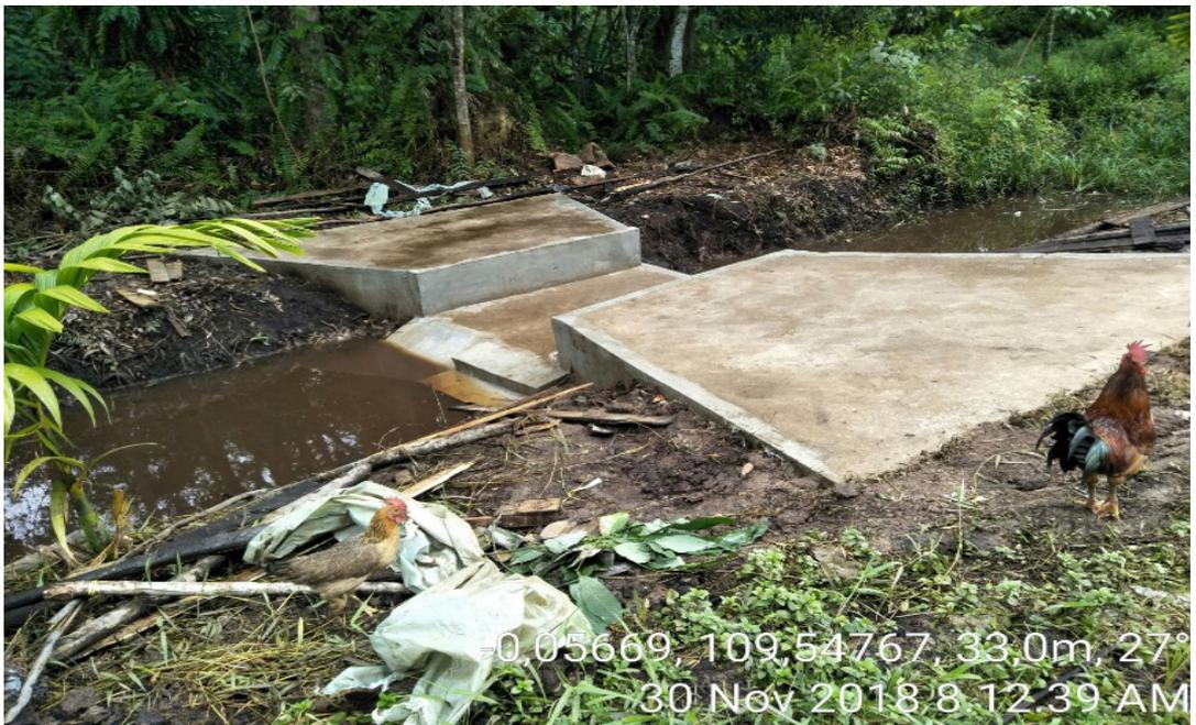
**GAMBAR 51** | Pengecoran lantai sayap sekat kanal
