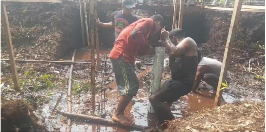
**GAMBAR 66** | Pemancangan Pipa PVC Beton Bertulang
