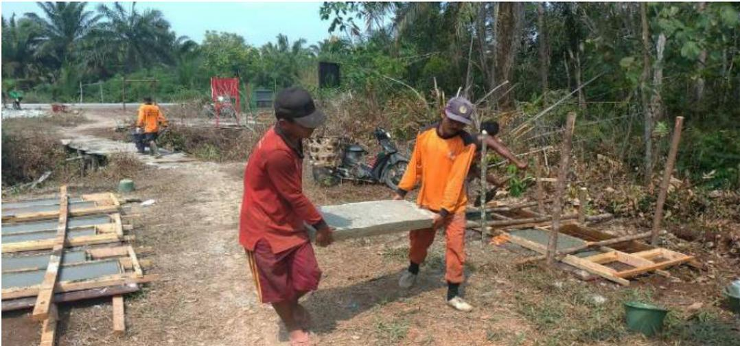
**GAMBAR 65** | Mobilisasi Panel Pracetak dan Pipa PVC Beton
