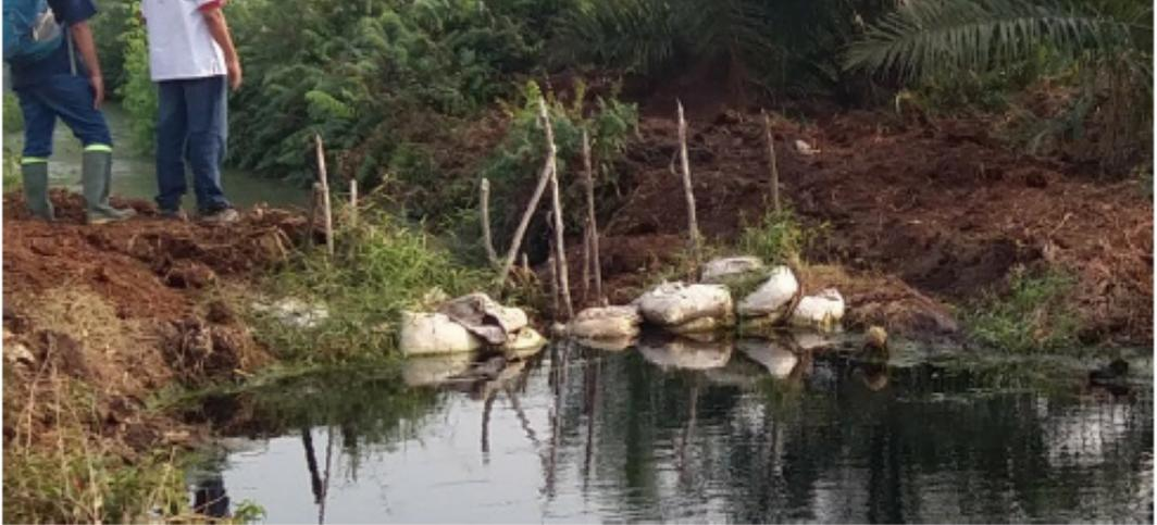
**GAMBAR 104** | Pemeliharaan korektif untuk sekat karung tanah
