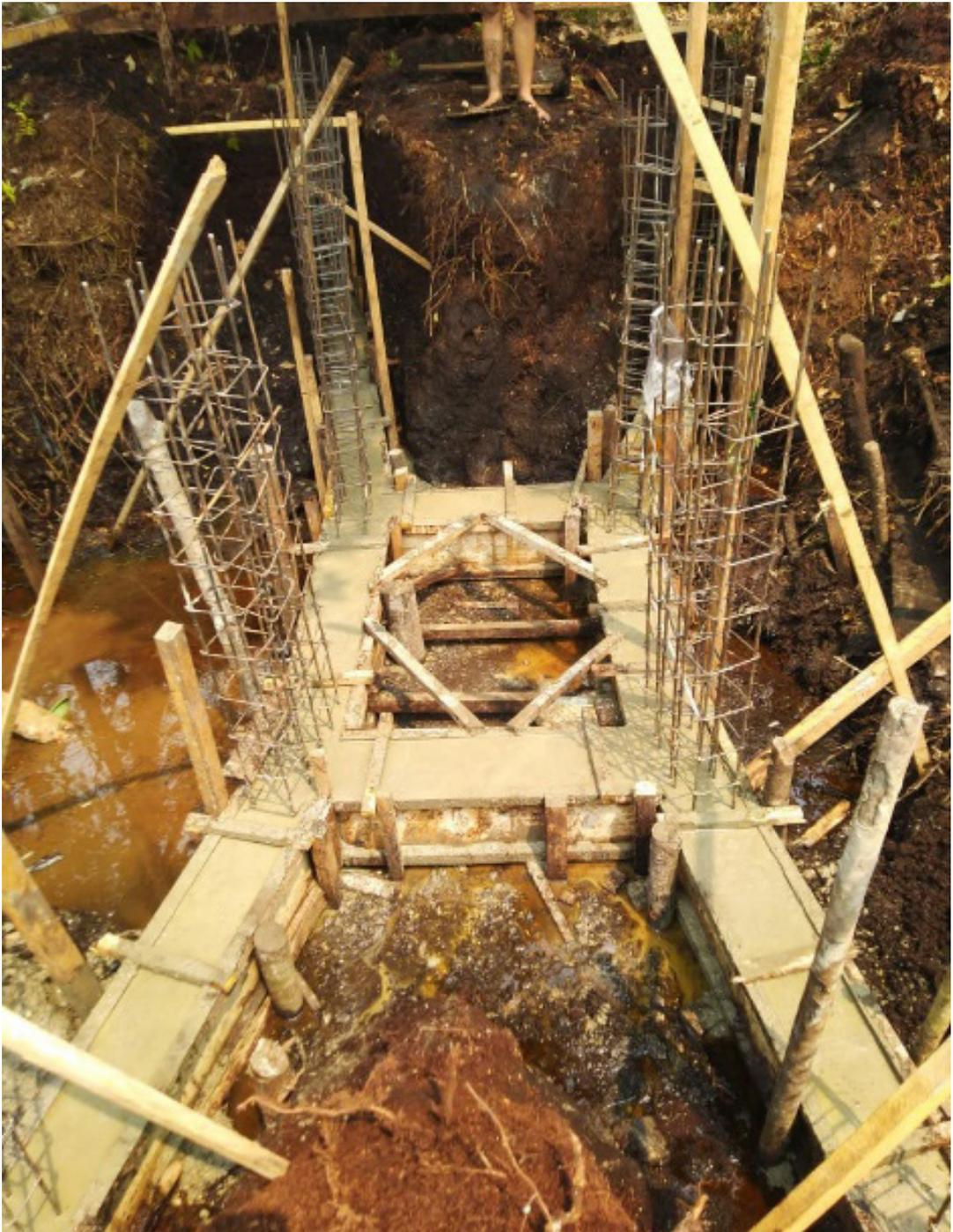
**GAMBAR 67** | Pekerjaan Konstruksi Sloof 20/30
