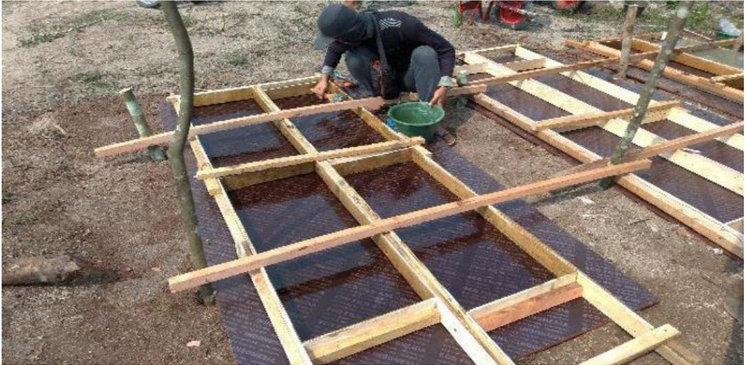
**GAMBAR 58** | Persiapan Pabrikasi Cetakan Panel Pracetak
