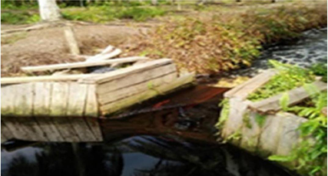
**GAMBAR 102** | Sekat kayu multilapis dengan kedua sayap yang rusak, membutuhkan pemeliharaan korektif
