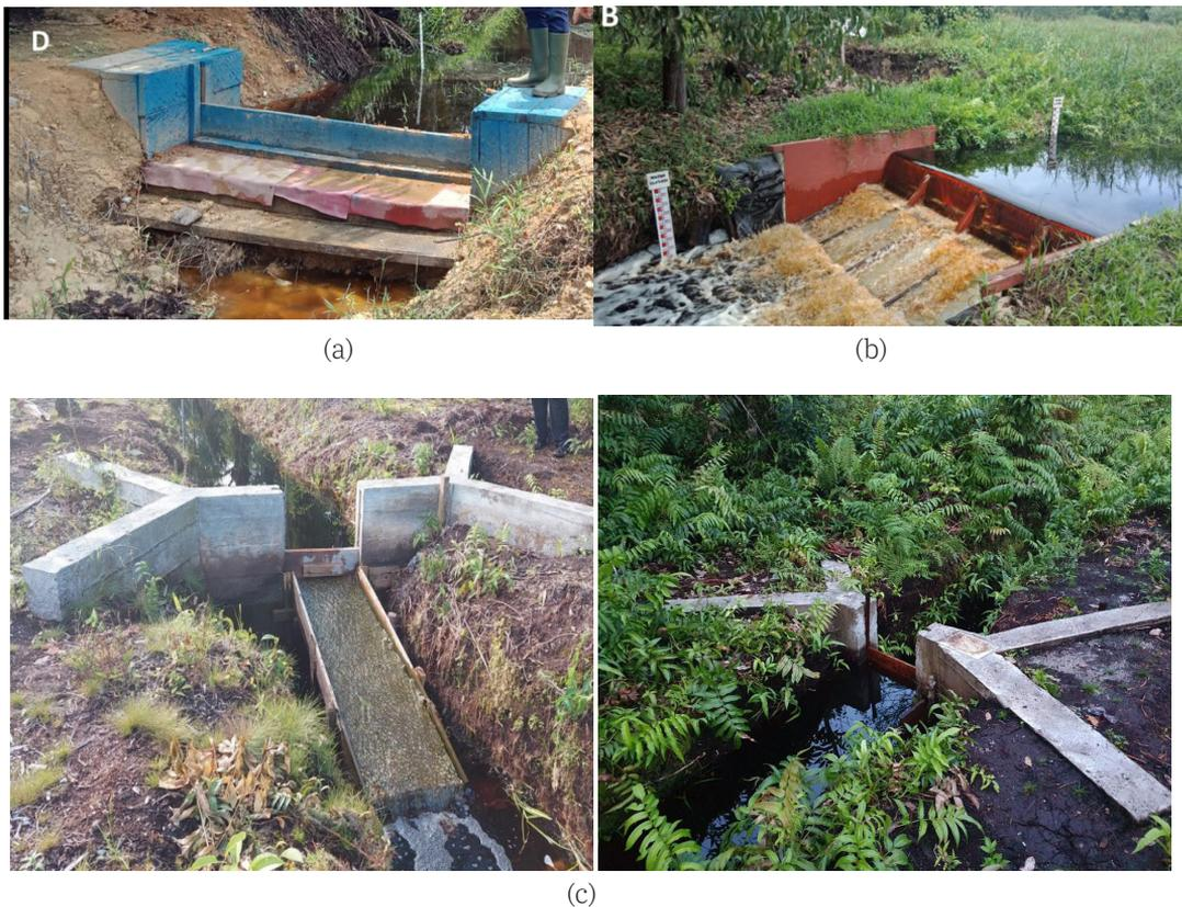
**GAMBAR 22** | Sekat Kanal dengan Pintu Air
