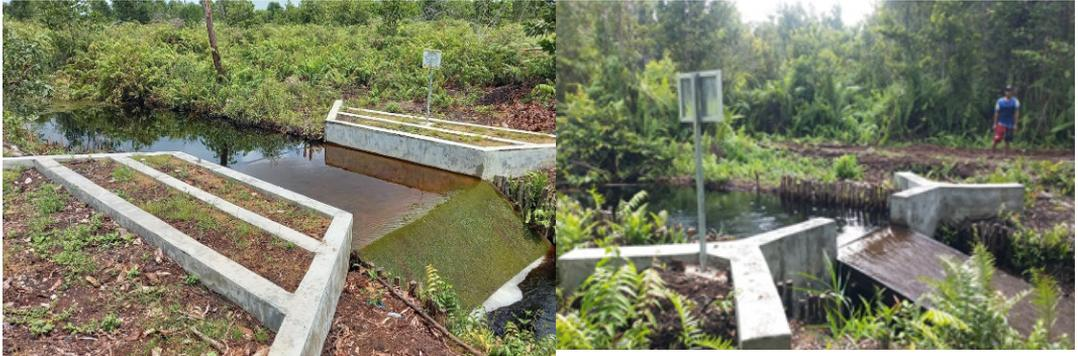
**GAMBAR 20** | Sekat Kanal Beton
