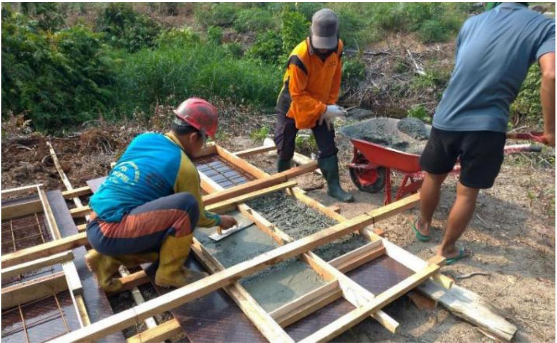
**GAMBAR 62** | Pengecoran panel pracetak
