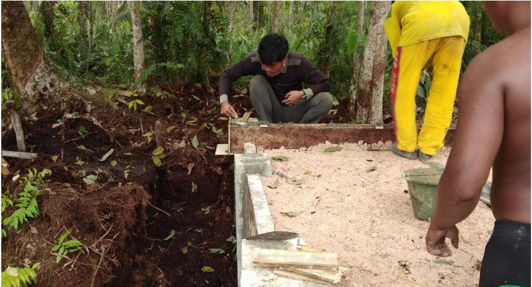
**GAMBAR 75** | Pembuatan balok pengaku
