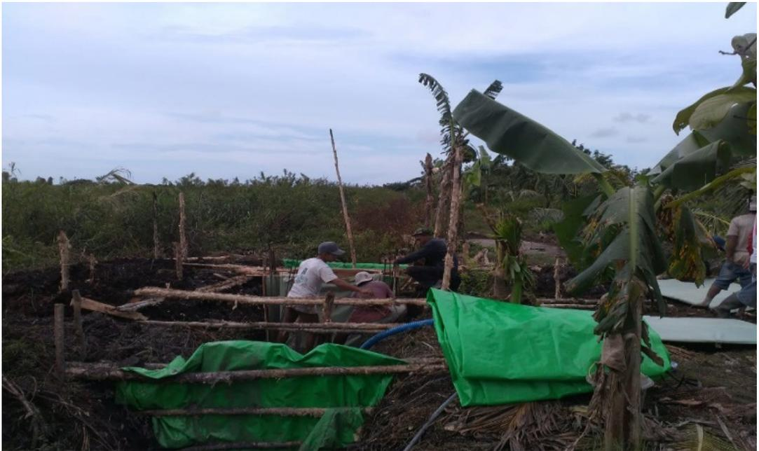
**GAMBAR 80** | Pengeringan atau “Coffering dan Dewatering”
