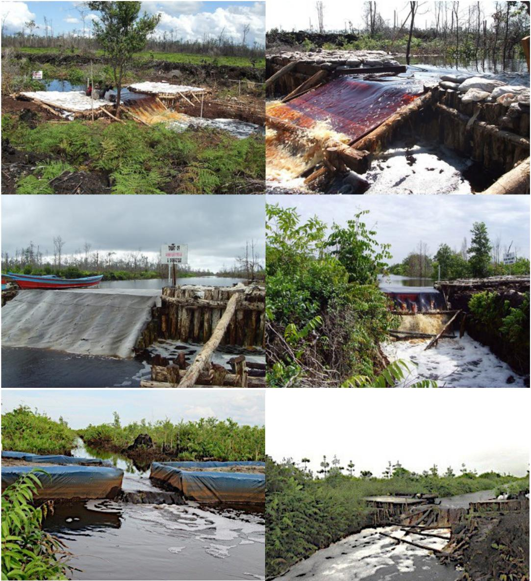
**GAMBAR 14** | Contoh gambar Sekat Kayu Dua Lapis dengan Sistem Peluap (spillway)
