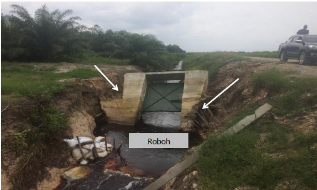
**GAMBAR 106** | Sekat Beton dengan kondisi rusak berat sehingga perlu dilakukan pemeliharaan rehabilitatif
