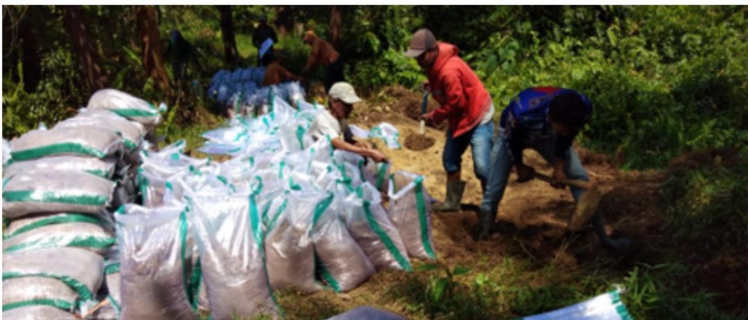
**GAMBAR 27** | Pembungkusan material tanah ke dalam karung
