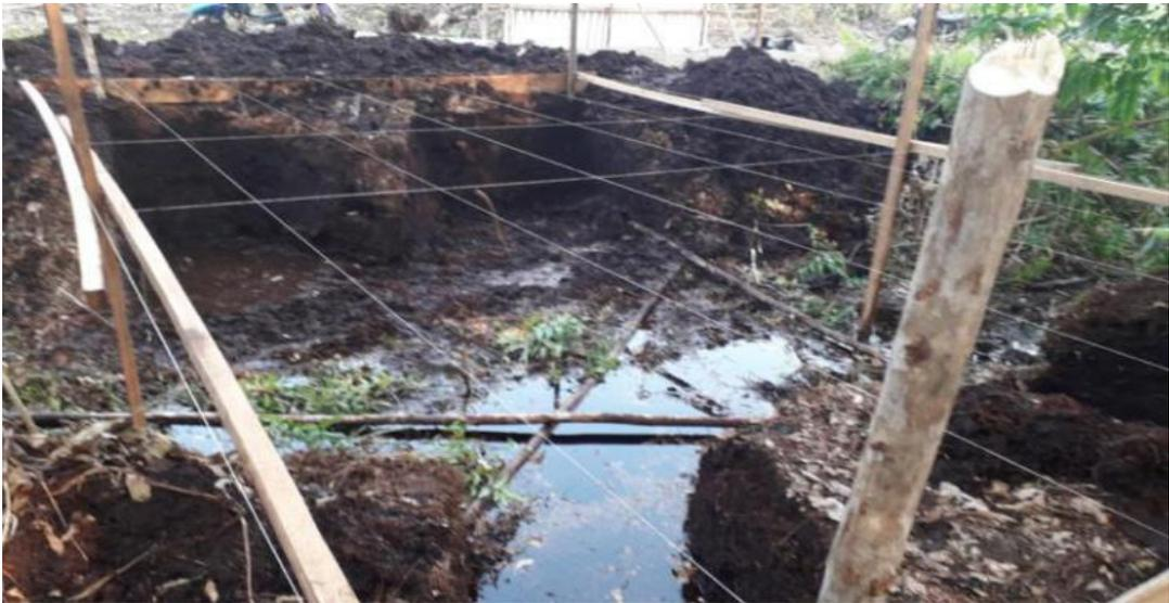
**GAMBAR 55** | Pengukuran dan Pemasangan *Bouwplank*
