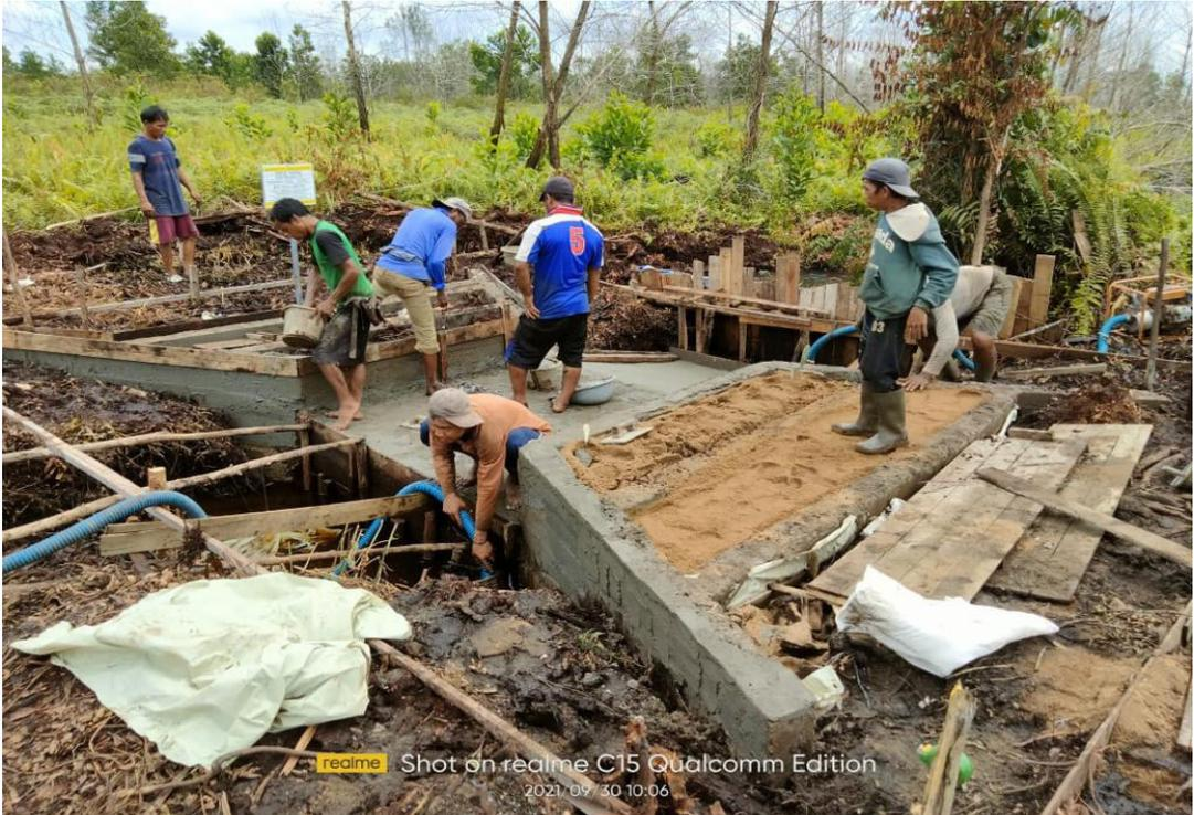
**GAMBAR 52** | Pembongkaran bekisting
