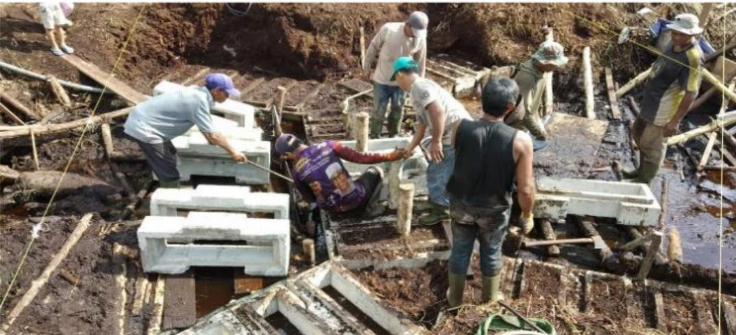
**GAMBAR 92** | Pemasangan *Hollow block* Pracetak
