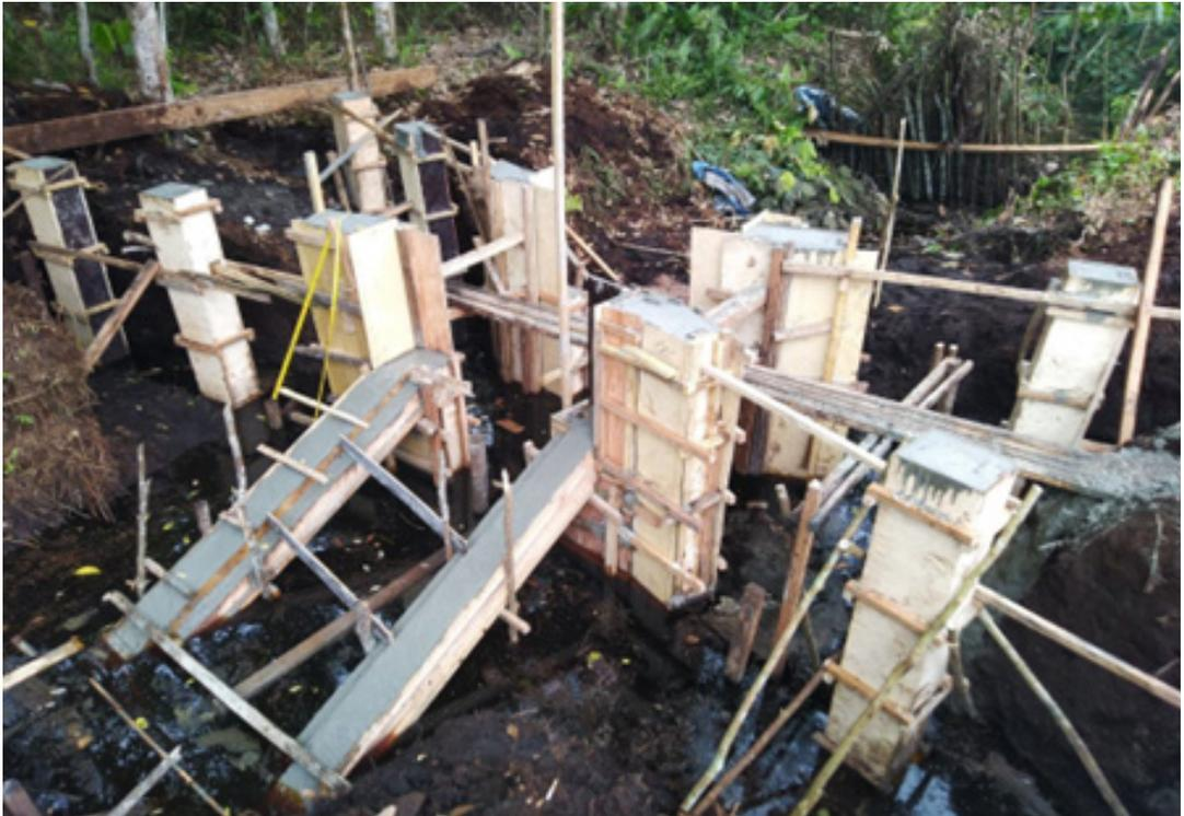
**GAMBAR 68** | Pekerjaan Konstruksi Kolom
