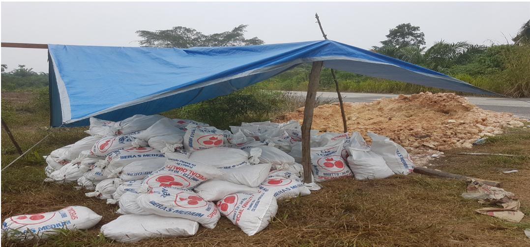
**GAMBAR 69** | Pembungkusan material ke dalam karung plastik
