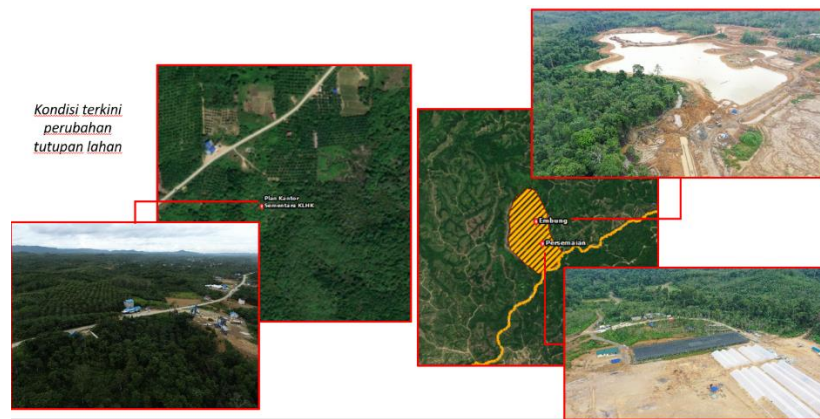
Gambar 97. Kondisi perubahan di lapangan terkait pembangunan IKN
